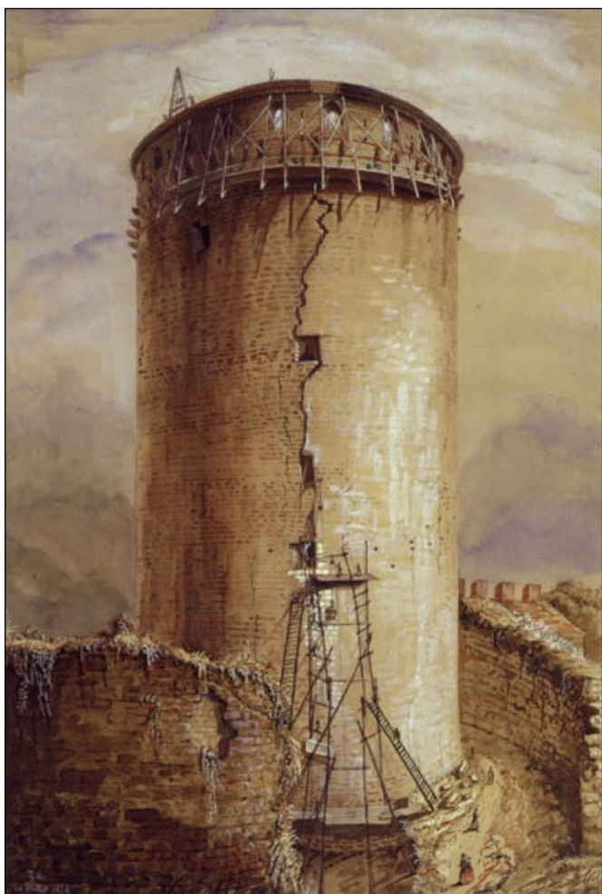
Fig. 1 – Vue de la grosse tour et de sa chemise depuis le sud en cours de restauration en date du 10 juillet 1856. Gouache de T. G (Théophile Grégoire ?). BnF Ve-140a, tome XI, fol. 9.
